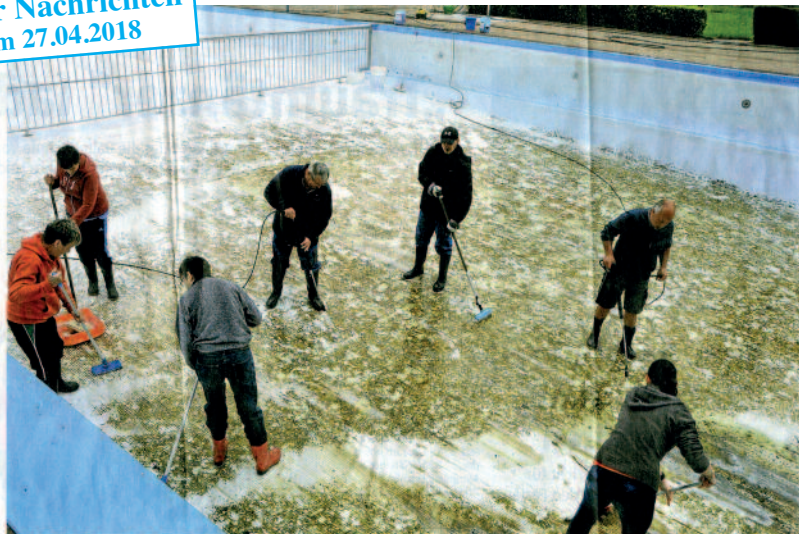
Viele fleißige Helfer vom SV Derne haben sich in dieser Woche die Gummistiefel angezogen und das Derner Freibad fit gemacht.
